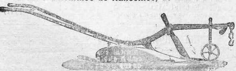
Estos arados combinan todas las ventajas de los mejores arados ingleses. Son muy uiertes en todas sus partes; el timón, el armazón y la mancera del lado de la tierra son de hierro forjado en una sola pieza, dándoles de este modo gran resistencia y evitando el
