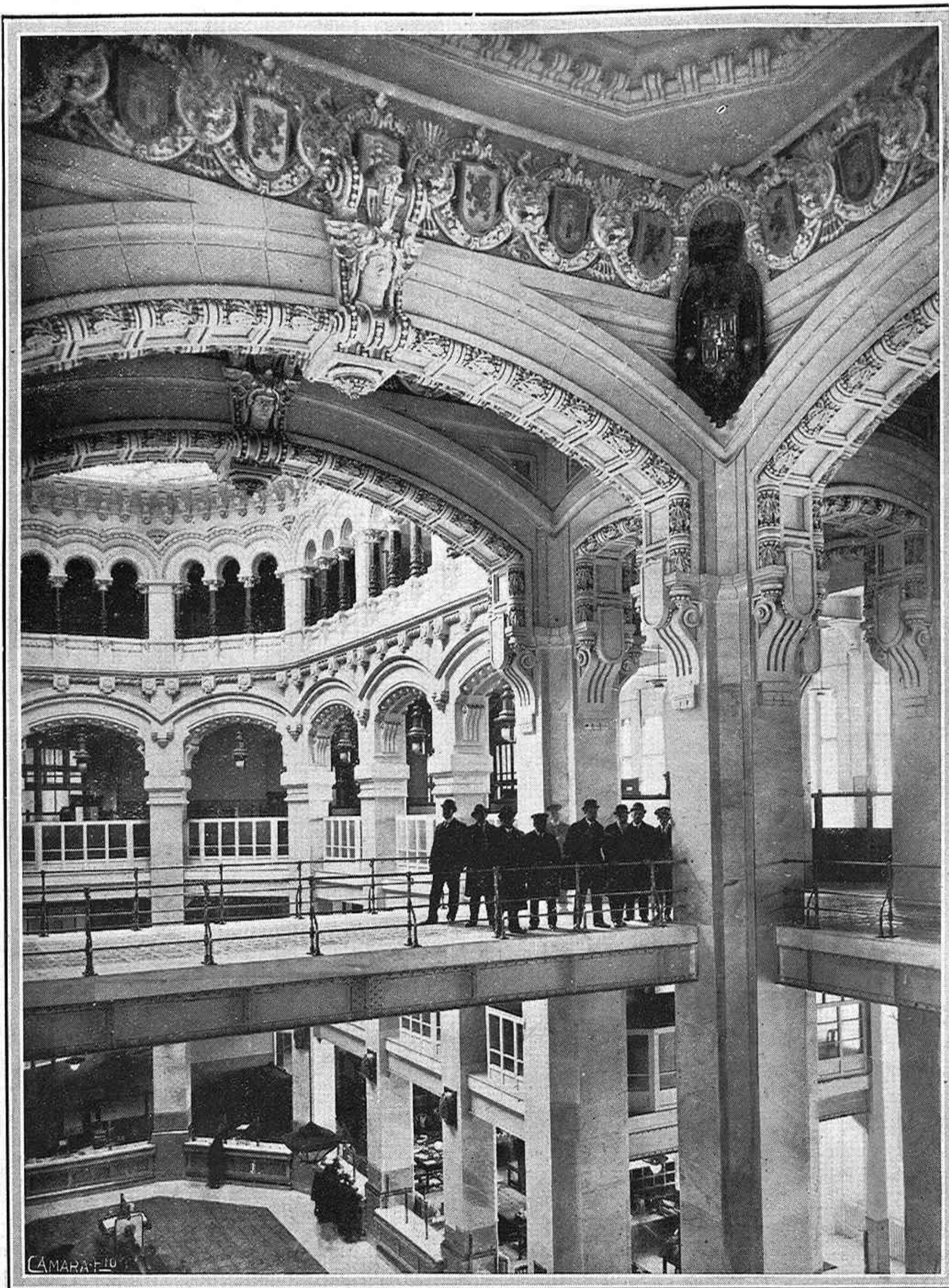
El gran "hall" central del Palacio de Comunicaciones de Madrid visto desde una de las galerías superiores
