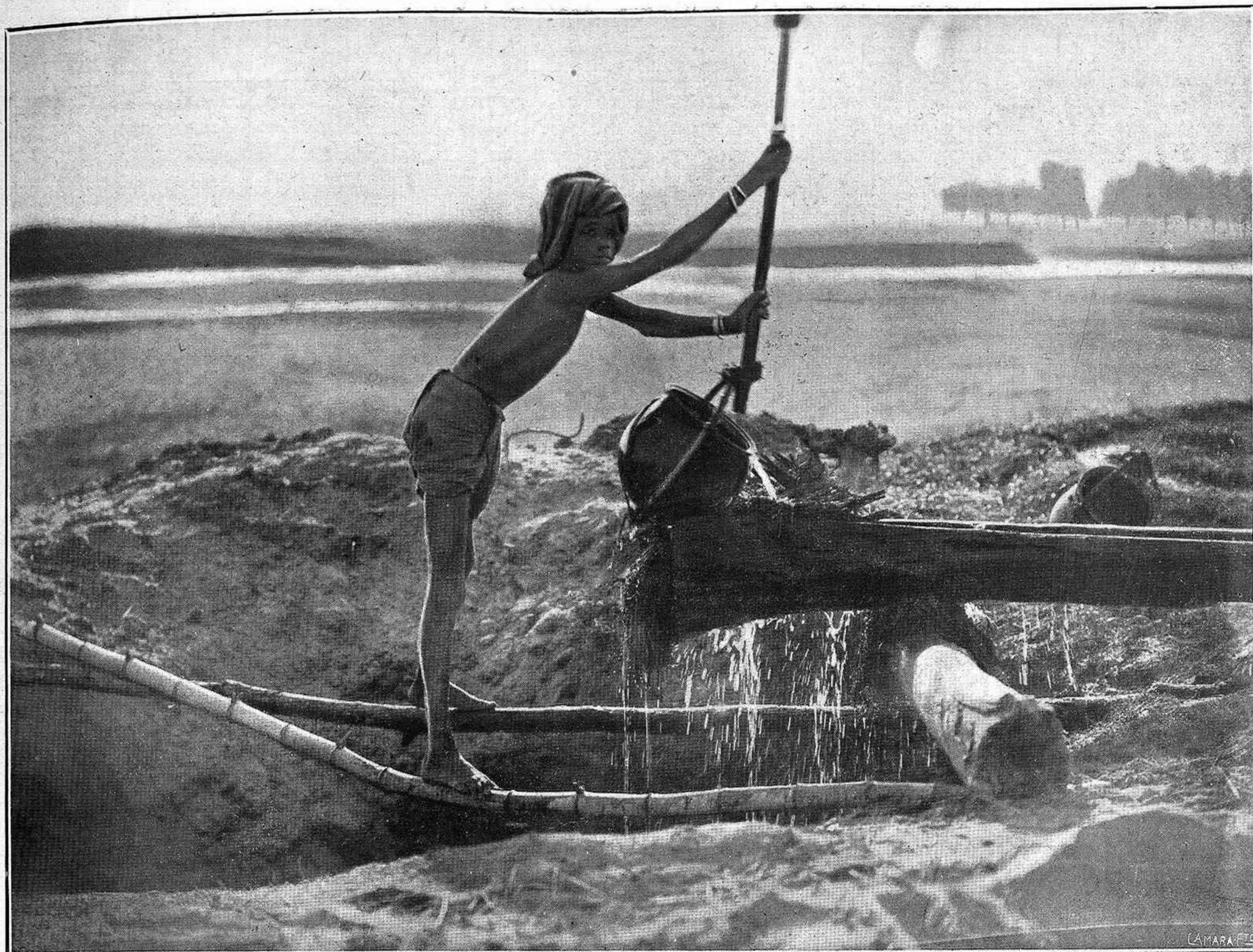
Primitivo sistema de extracción de agua de un pozo
