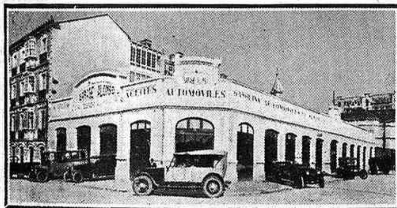
Vista exterior de uno de los garages
