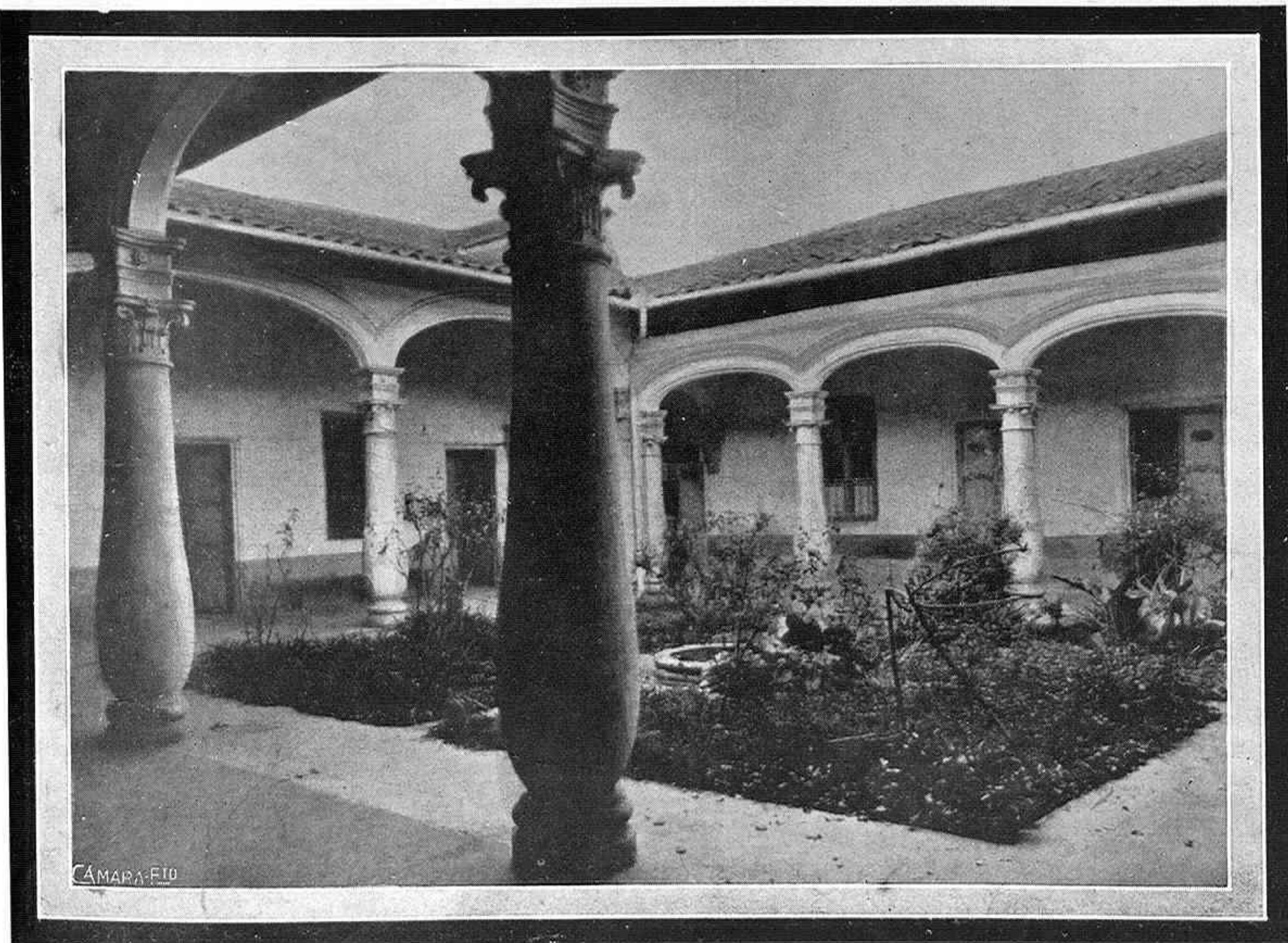
Columnas de doble capitel, esbeltas y sencillas; corredor con su techo de madera y el patio con su jardín típico, del Colegio Chaves
