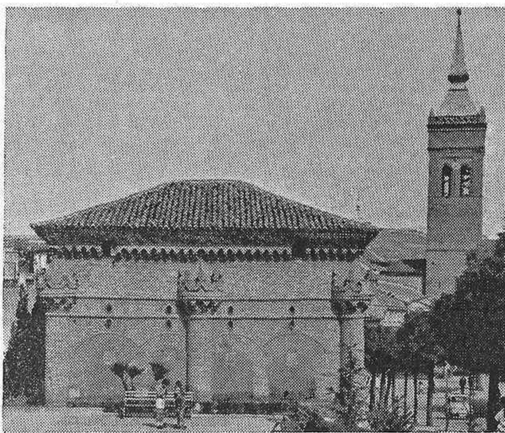
Capilla de Luis de Lucena, monumento al que se hace referencia en el estudio, del que se denuncia su alto grado de humedad en la parte baja (Foto: Archivo)
