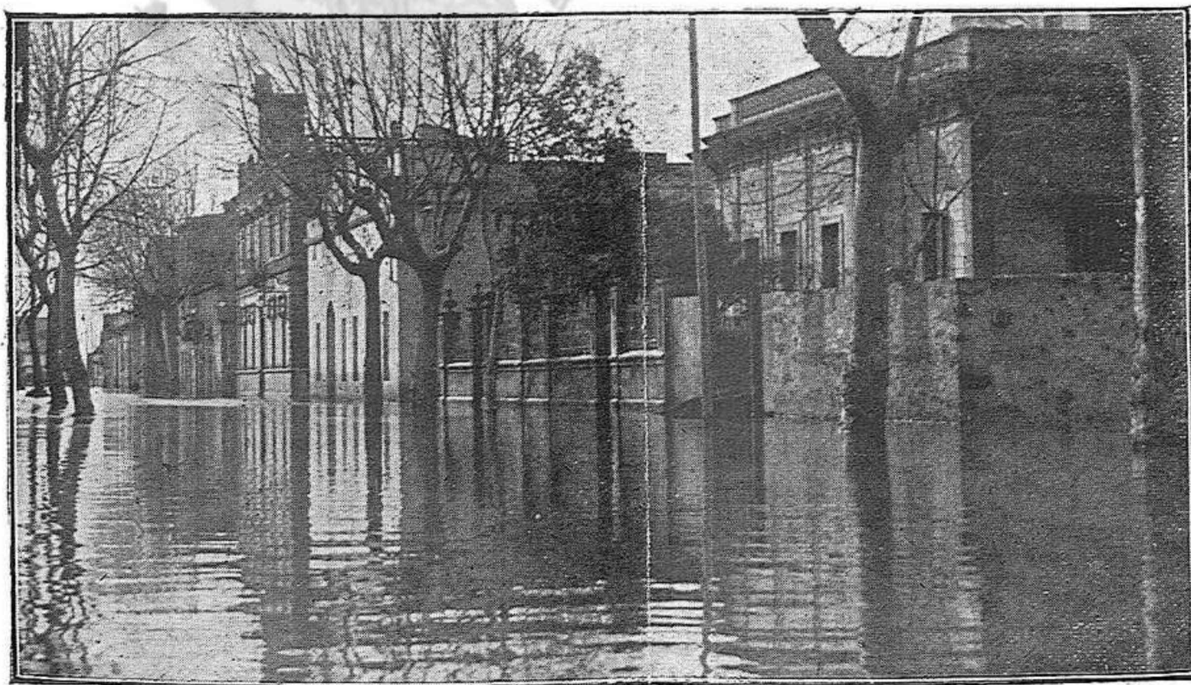
Aspectes de la carretera de Girona convertida en riu.
