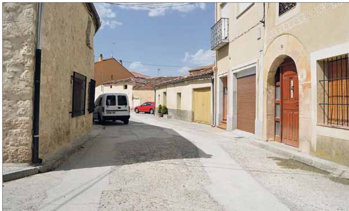
Los vecinos denuncian el mal estado del pavimento de varias calles y de las redes de abastecimiento. / CRISTINA YUSTA
