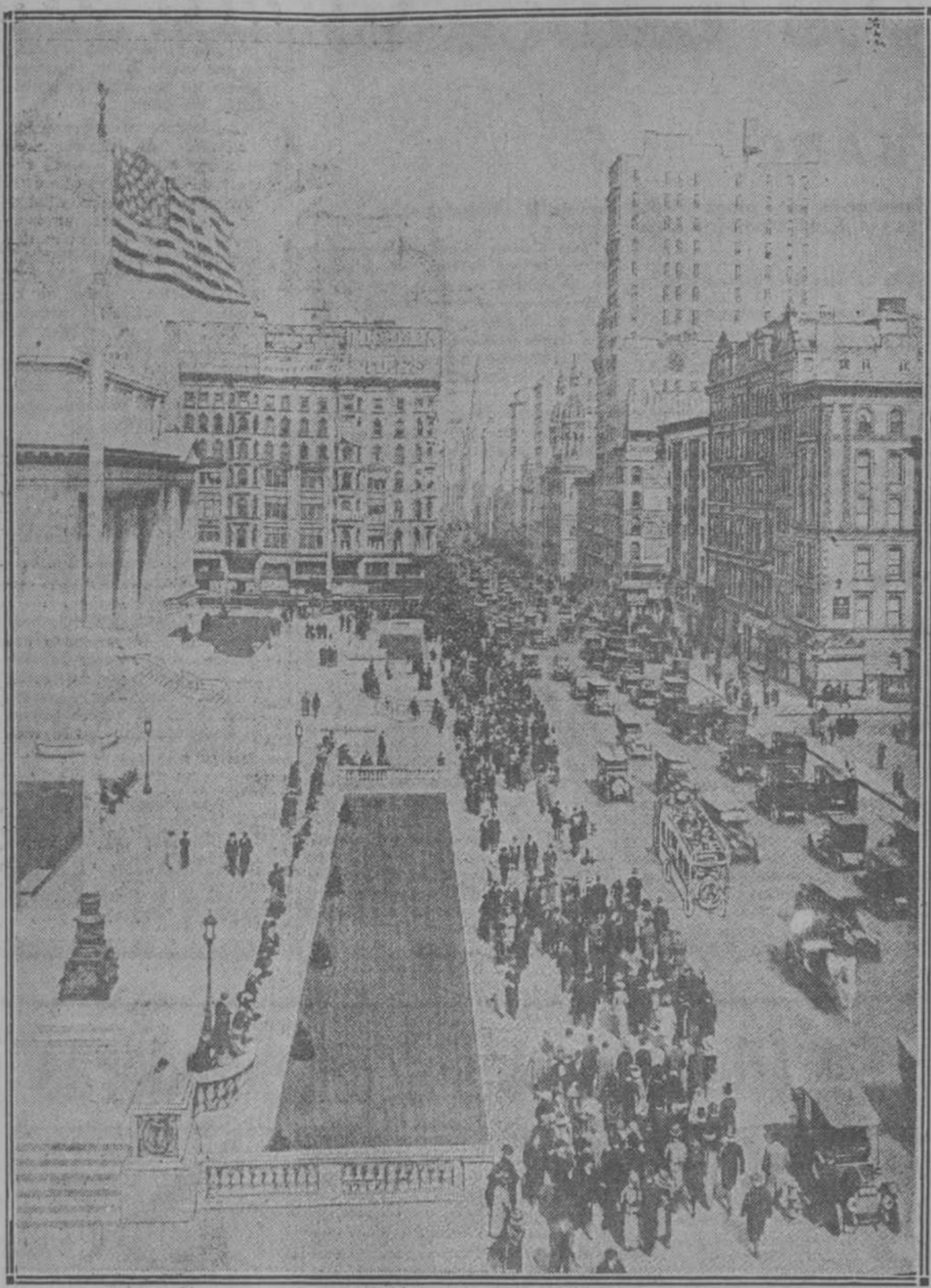
—¿En dónde queda la Quinta Avenida? (Un aspecto de ésta a la altura de la calle 42, el corazón de Nueva York.)
