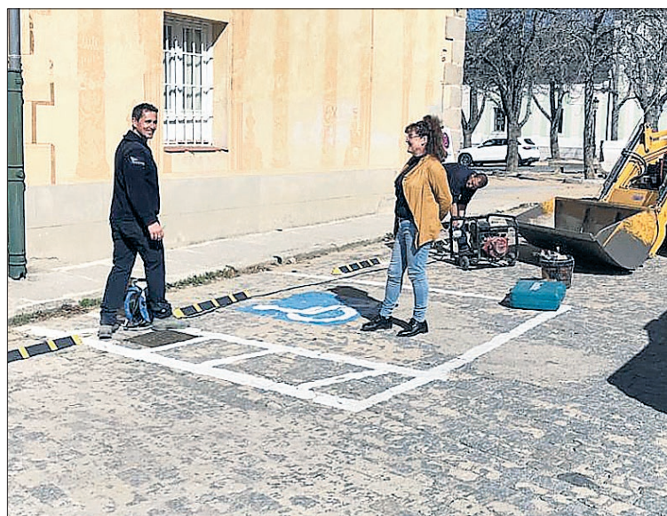
Las obras comenzaron el pasado martes por la zona de caballerizas. / AYUNTAMIENTO
