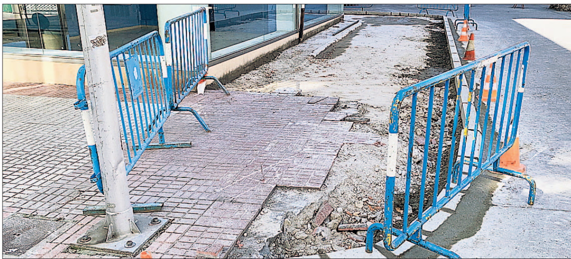
Obras en la acera de la calle Severo Ochoa. / C. NÚÑEZ
