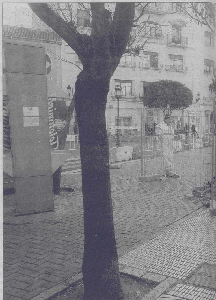
La maquinaria ha empezado a retirar el pavimento en la zona de obras. / R. SERRALLÉ
