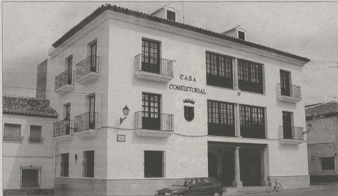
Fachada de la Casa Consistorial de Munera. / J.M.
