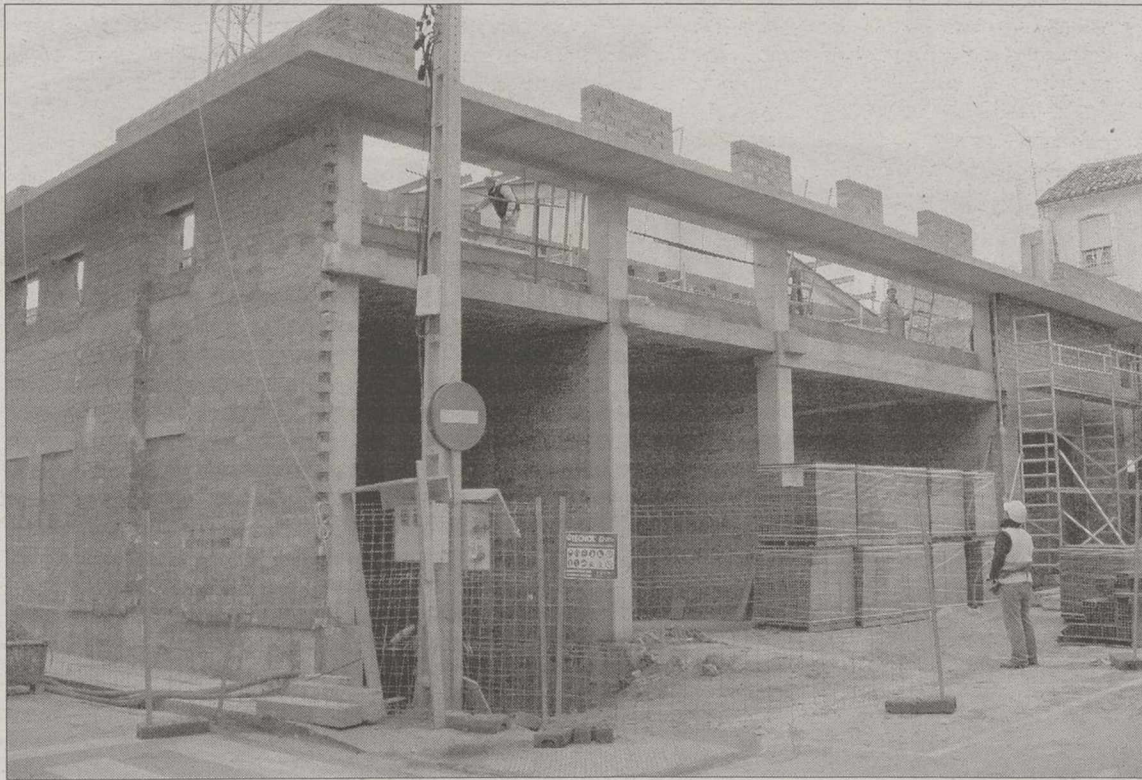
Varios obreros trabajan en el nuevo edificio del mercado. / ANGEL ROMERO
