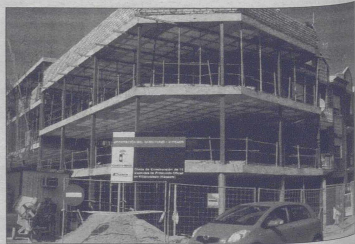
Viviendas en régimen de alquiler en construcción junto al barrio Asturias. / T.J.
