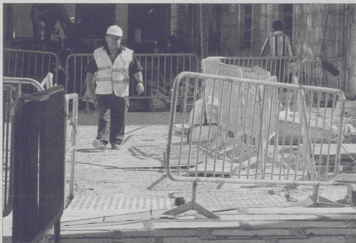
Un trabajador de la construcción se ocupa en las obras de remodelación del pavimento de una calle. / M.A.V.
