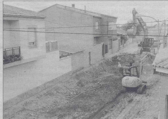
Obras en la calle Avenida. / M. PICÓ
