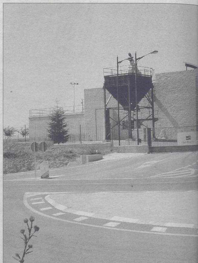
La planta de nanofiltración se instalará junto a la ETAP. / LA TRIBUNA
