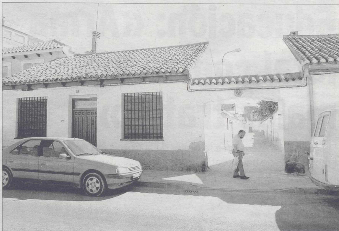
Según la LOTAU, los edificios deben pasar forzosamente una inspección técnica de seguridad. / ARTURO PÉREZ
