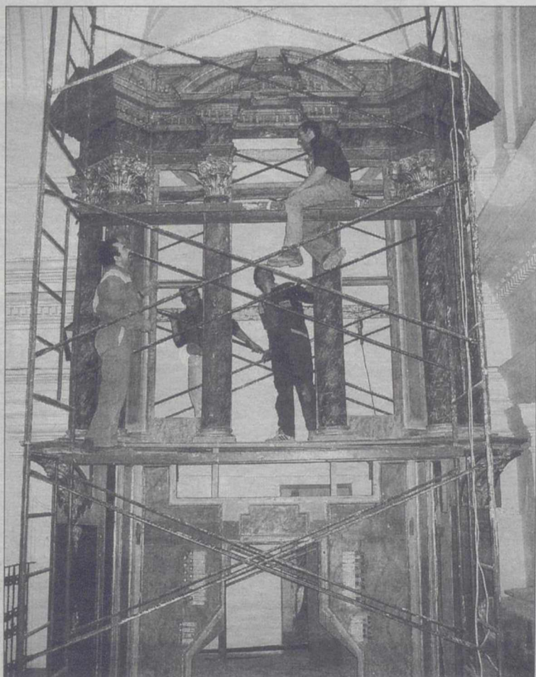
Vista de los trabajos preliminares en el órgano. / J. GARCÍA
