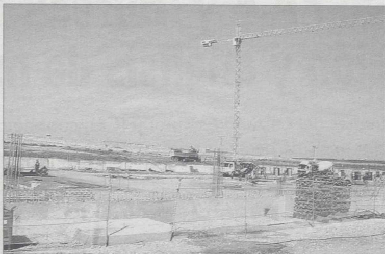
Obras del Hospital Comarcal de Villarrobledo. / TERESA JIMÉNEZ
