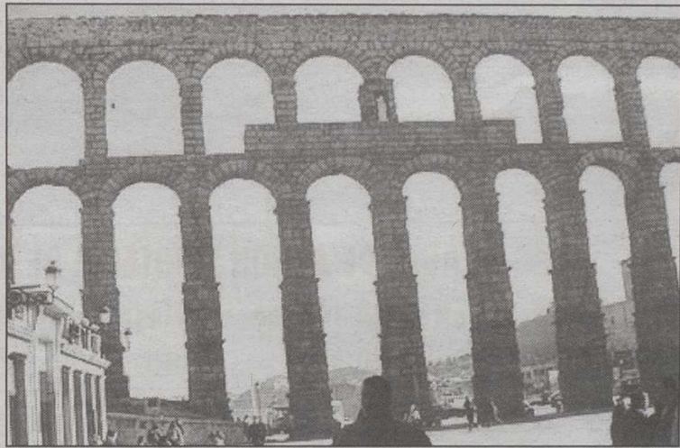
Vista del acueducto de Segovia.
