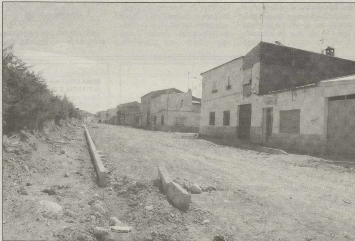
Estado actual de las obras de la vía.
