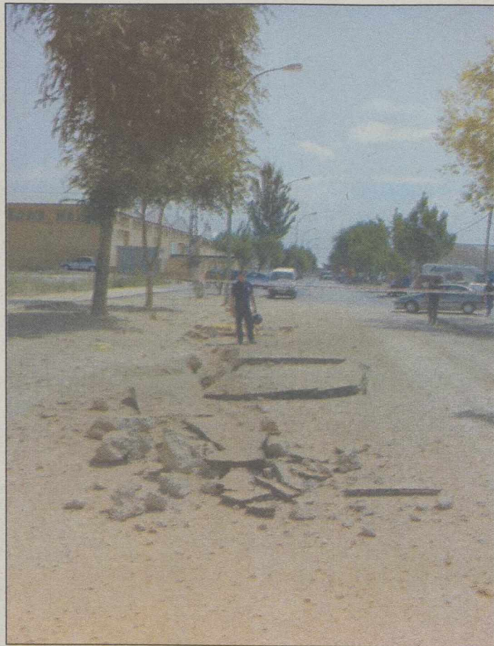
Una imagen del estado de la calle tras la explosión.
