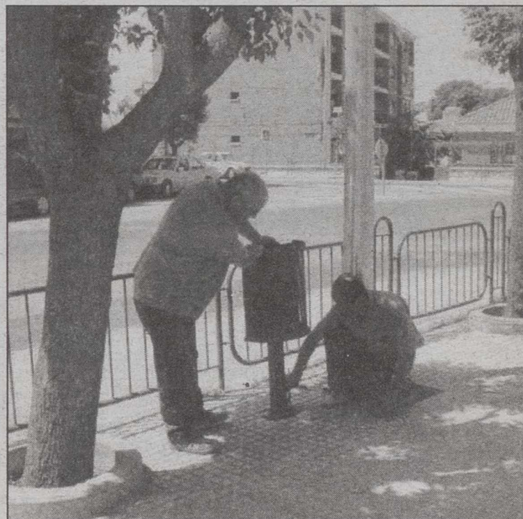
Instalación de las nuevas papeleras de Hellín.
