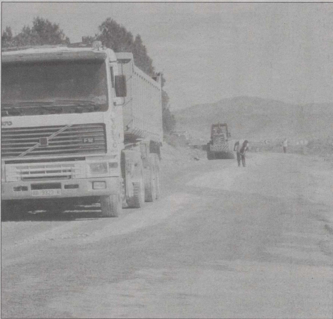
Se iniciaron las obras en la carretera Hellín-Agramón.
