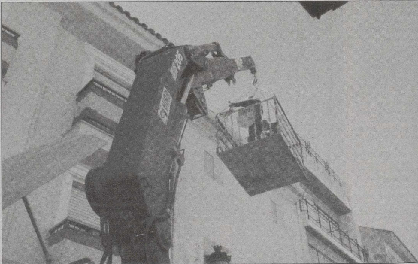
Ha comenzado la eliminación de cornisas peligrosas.
