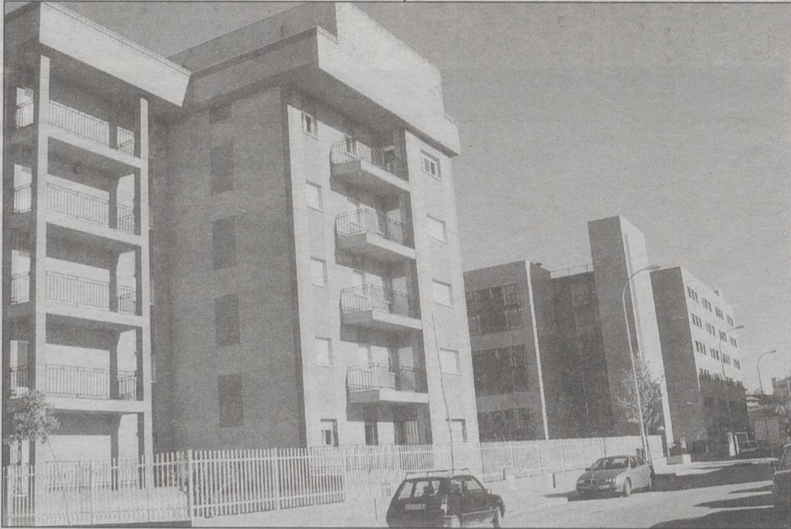
El bloque de 35 viviendas (i) está al lado de los apartamentos para jóvenes.
