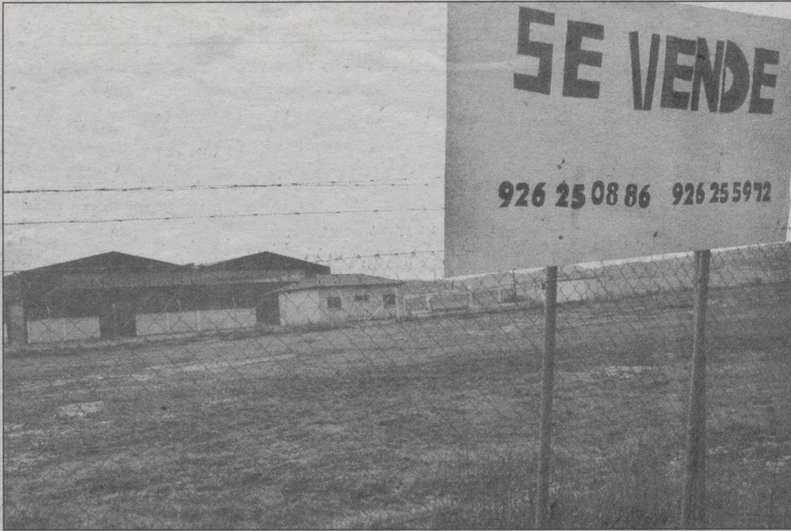
Instalación de Colisur-2000 en la localidad de Picón, en Ciudad Real.
