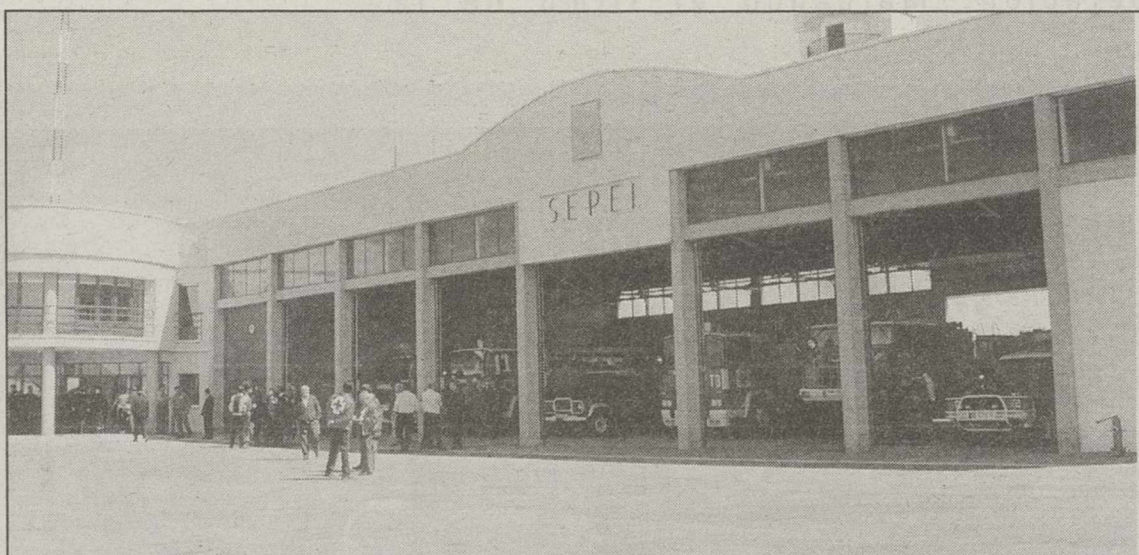
Instalaciones del Parque Comarcal de Bomberos.
