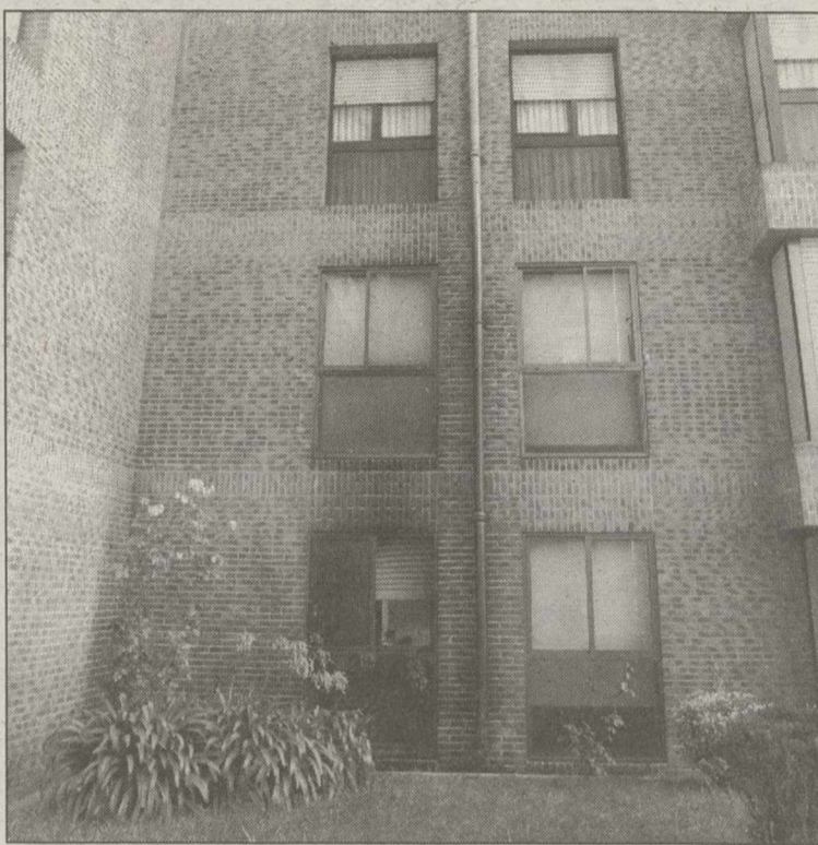
Destrozos en una vivienda de la calle Laniomendi de Getxo.
