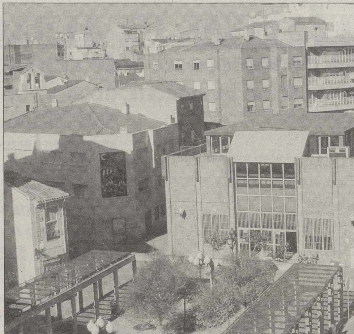
Se acometen diversas reformas en el barrio de Carretas dentro de las actuaciones del Urban.
