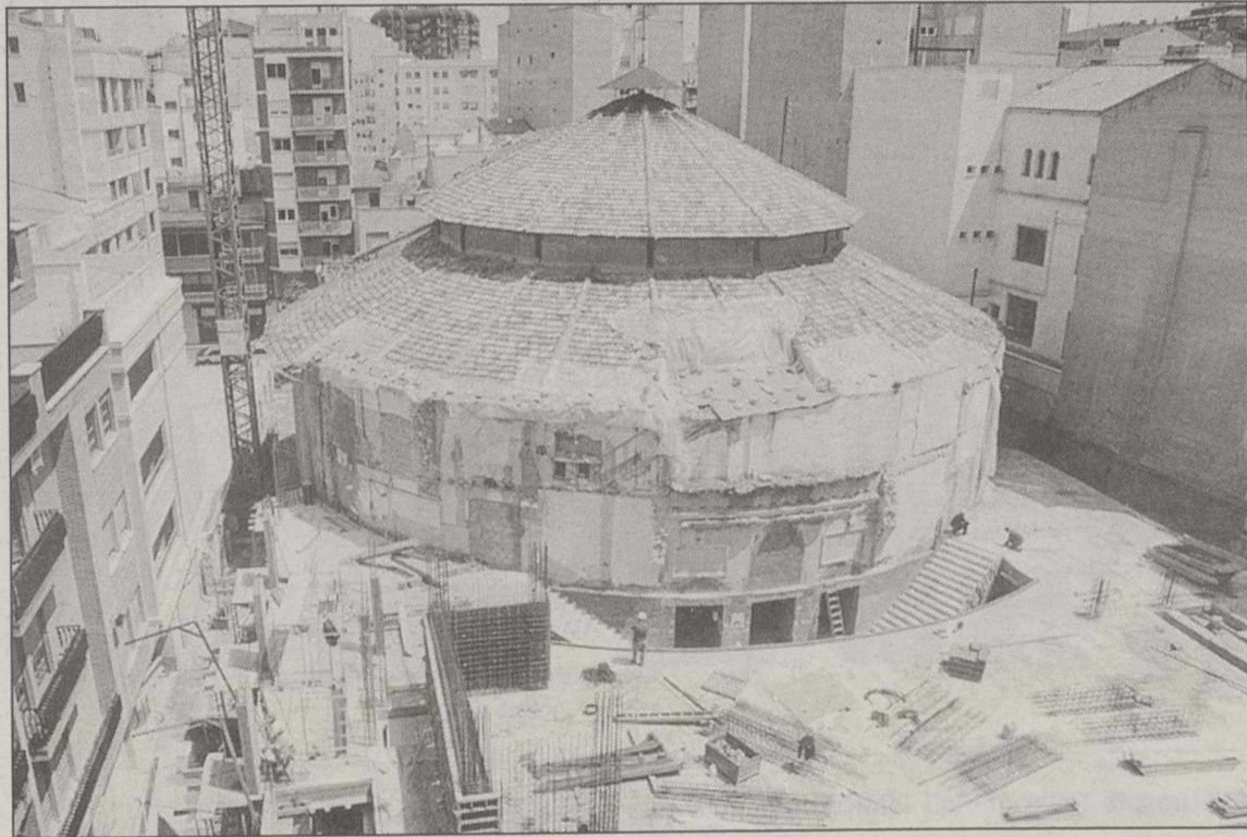
Las obras de rehabilitación se encuentran muy avanzadas.
