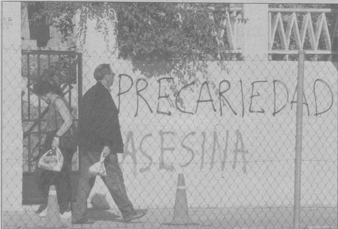
Pintada aparecida junto al Hospital de Valdecilla tras el hundimiento de la fachada. EFE
