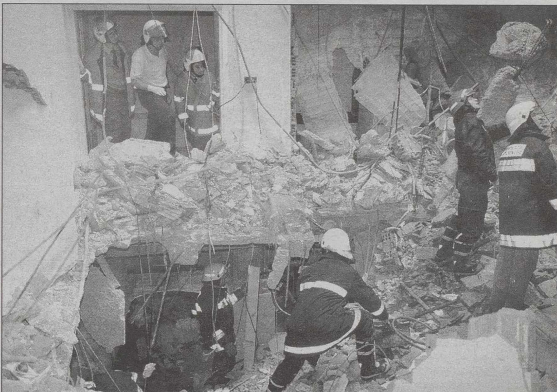
Se desplomó la fachada del edificio de Traumatología del centro sanitario, ocasionando la muerte de cuatro personas.
