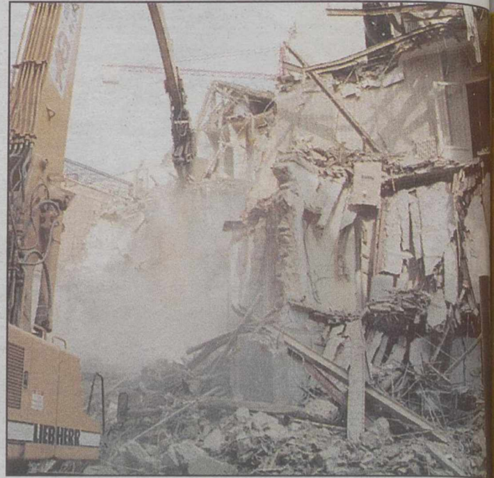
El cuerpo demolido corresponde a una transformación de los años 40.
