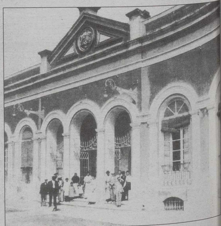
Antigua fachada del Teatro Circo, anterior a la que ayer fue derruida.
