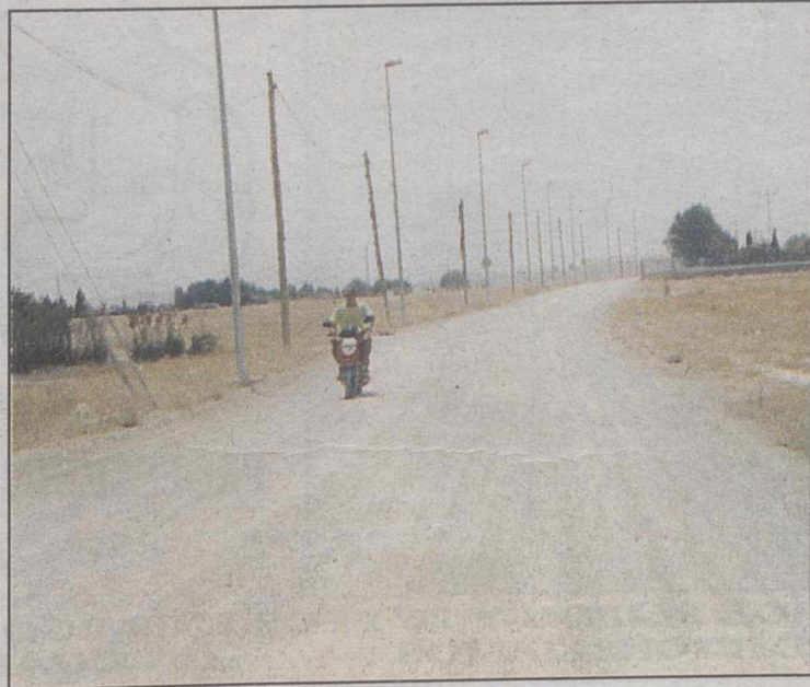
El camino a la Ciudad Deportiva no será asfaltado, de momento.
