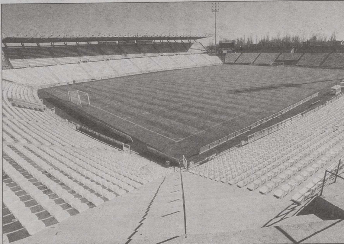
Se han encontrado muchas deficiencias en el nuevo Carlos Belmonte.
