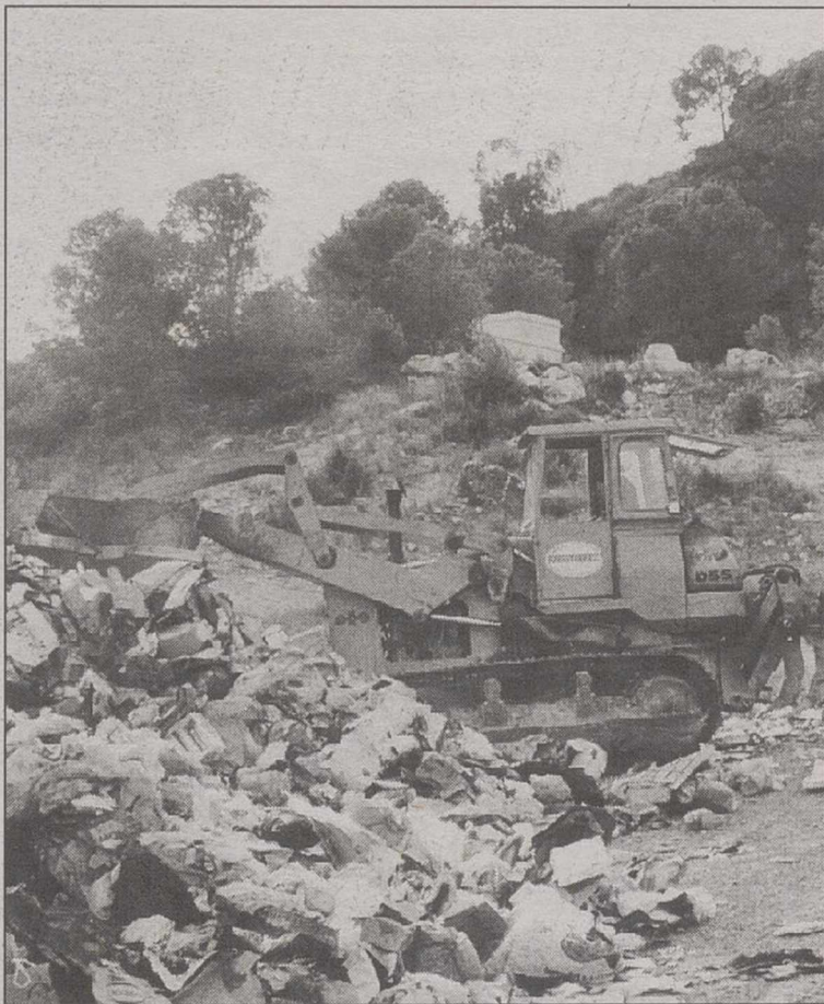
Comenzaron los trabajos de acondicionamiento en Las Grajas.
