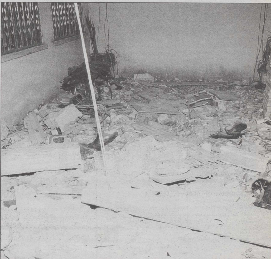
La explosión se produjo en un piso de la sexta planta de un inmueble en la Gran Vía.
