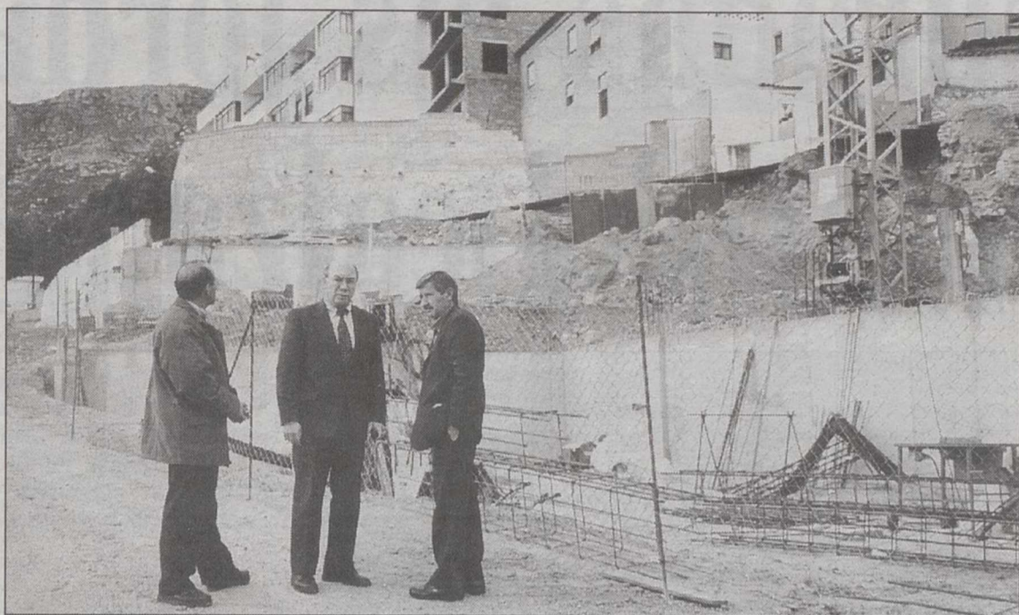
Angel Galán y José García durante la visita a las obras en la calle Travesía Ancha de Yeste.
