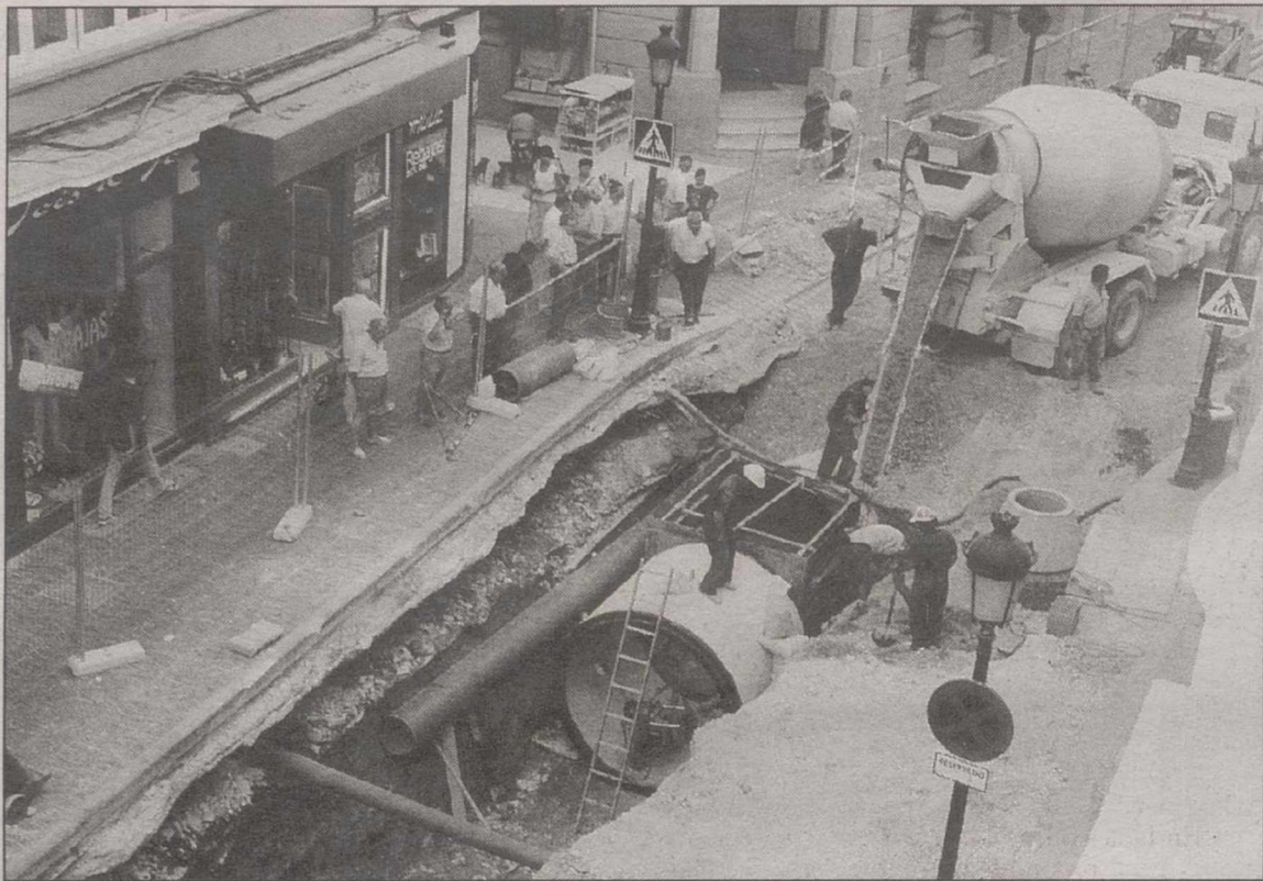
El Ayuntamiento repartirá subvenciones entre los comercios afectados por las obras del colector.
