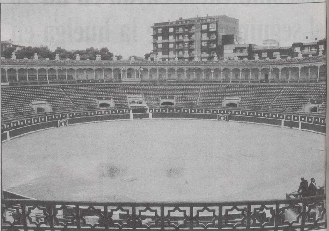
La empresa Aplyseal ha realizado trabajos en la Plaza de Toros por valor superior a los 40 millones.
