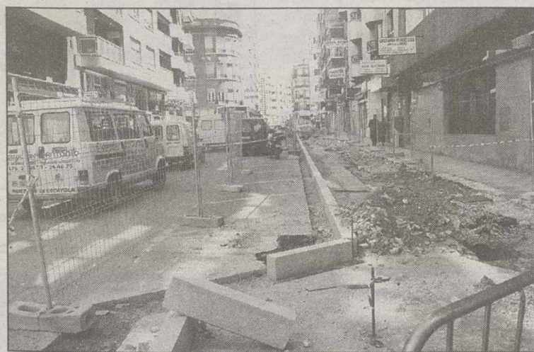
Obras de pavimentación, asfaltado y acerado.
