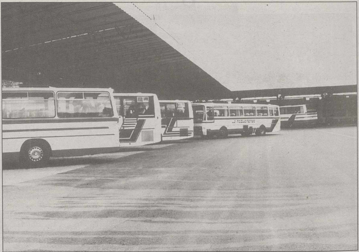
El patio de dársenas de la estación se cubrirá en su totalidad.
