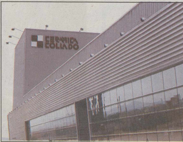
Edificio de "Cerámica Collado" en Almansa.
