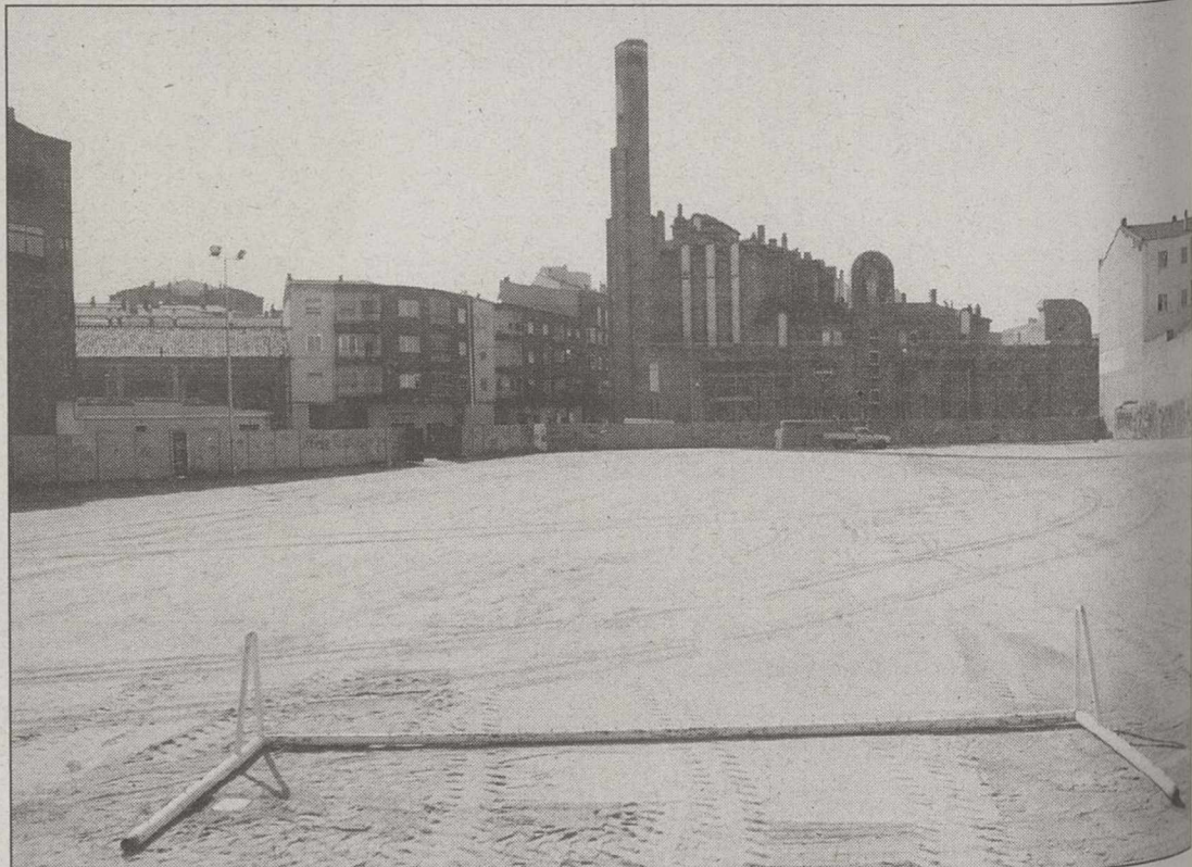
En este solar se construirá el nuevo polideportivo cubierto, cuyas obras fueron ayer adjudicadas.
