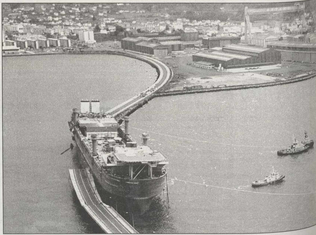
El Puente As Pías, dañado por el choque de la plataforma petrolífera "Discoverer Enterprise".
