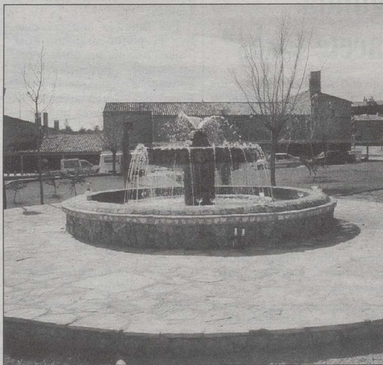
Las deficiencias son muy importantes en Cañada de Agra.
