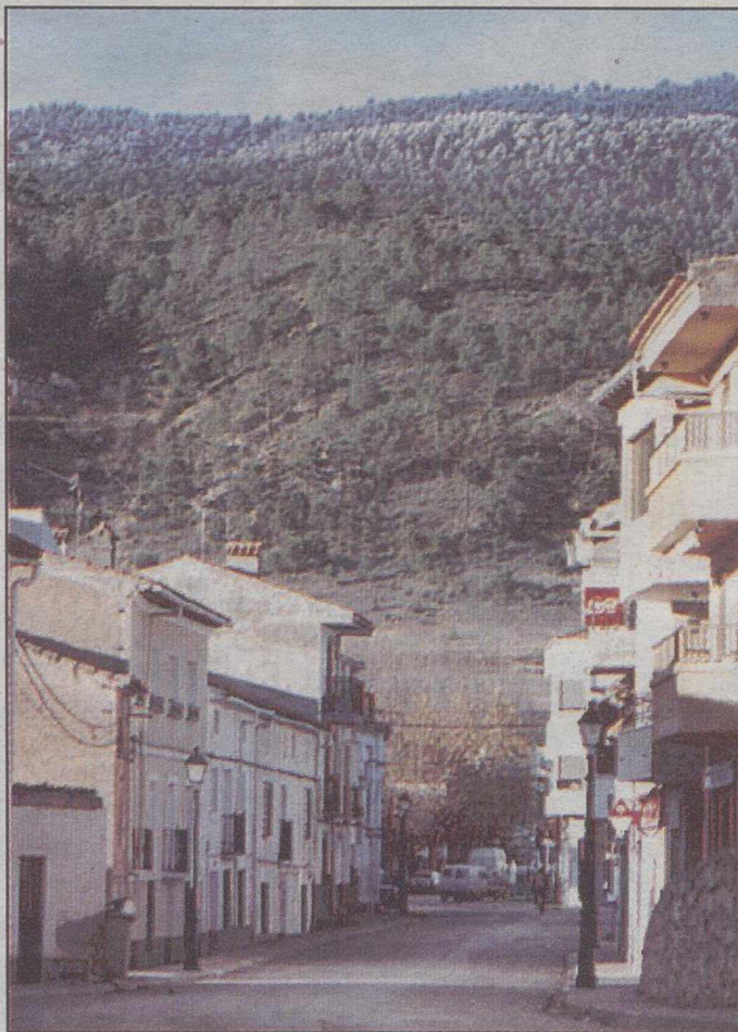
Riópar cuenta con un nuevo Centro de Salud.
