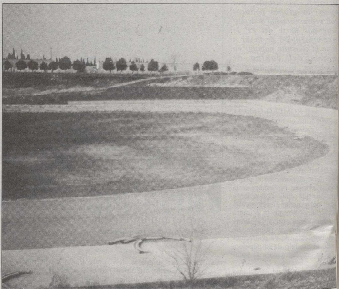
La empresa JOCA iniciará próximamente las obras de reparación de la pista de atletismo.
