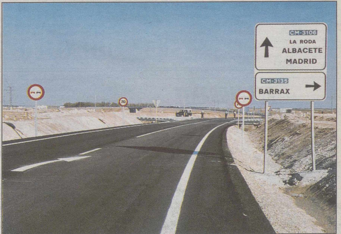
El tramo de la carretera CM-3121 que une Villarrobledo y Barrax verá reforzado su firme.
