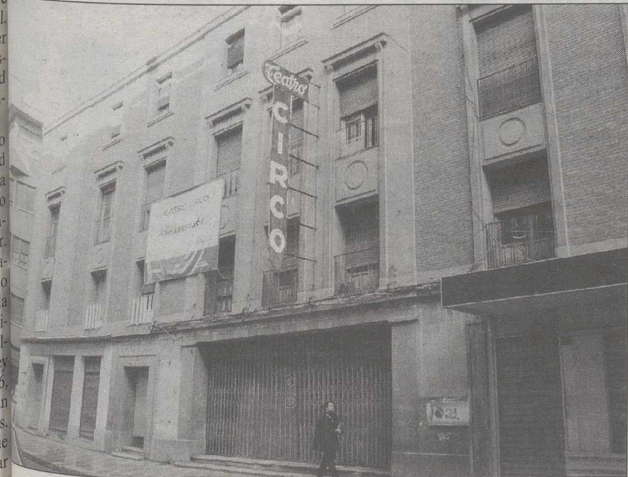
Teatro Circo, uno de los deterioros más clamorosos.
