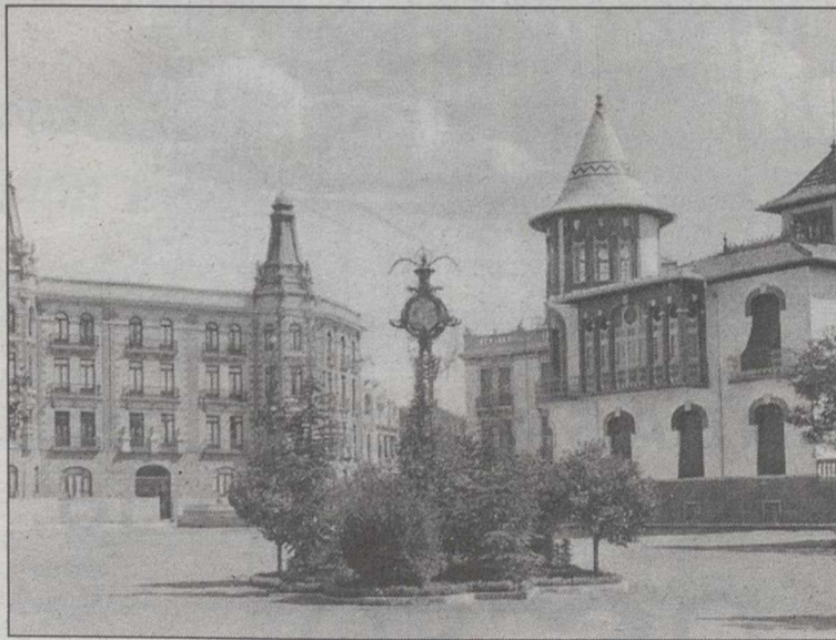
La destrucción del edificio Rotonda, entre las pérdidas más importantes.
