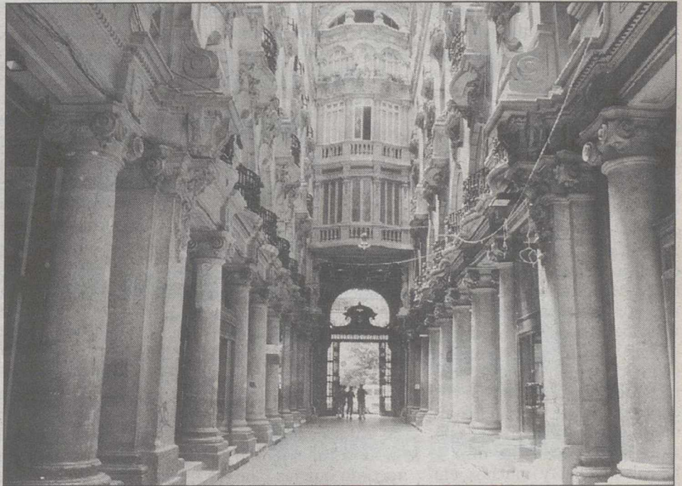
La rehabilitación del Pasaje de Lodares, otra asignatura pendiente.
