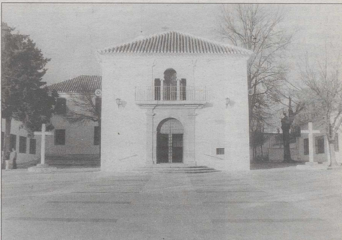
Romera informó sobre las obras en los alrededores del Santuario de Nuestra Señora de la Caridad.
