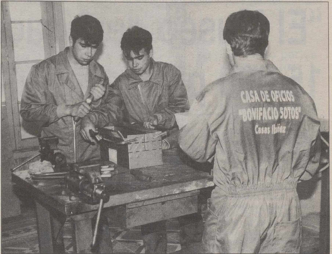
Casa de Oficios "Bonifacio Sotos" de Casas Ibáñez.
