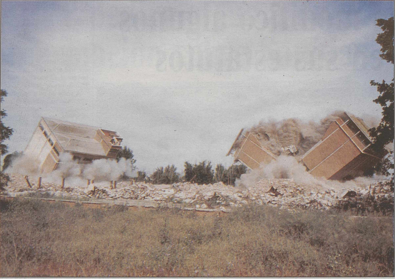
A las diez en punto de la mañana los explosivos acabaron con los dos últimos bloques de la fábrica del Aguila.
