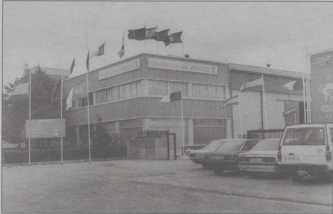
Vía libre para realizar obras en la sede del ITAP y en las naves de Expovicaman.
