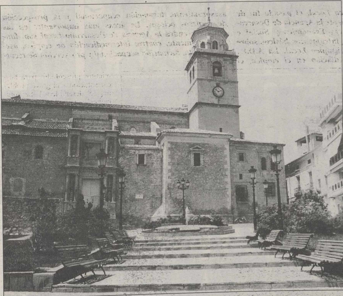
La instalación de la alarma en la iglesia de la Asunción ya es un hecho.
